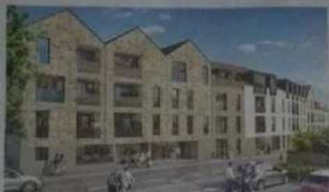
Nafilyan & Partners est en train de construire, rue des Remparts, 94 logements, dont 30 % de sociaux.
